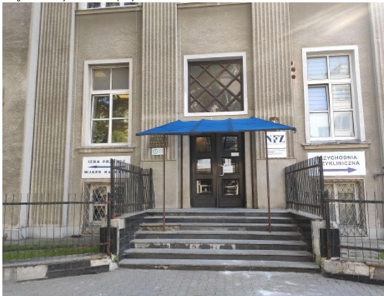
widok aktualny - elementy do rozbiórki
