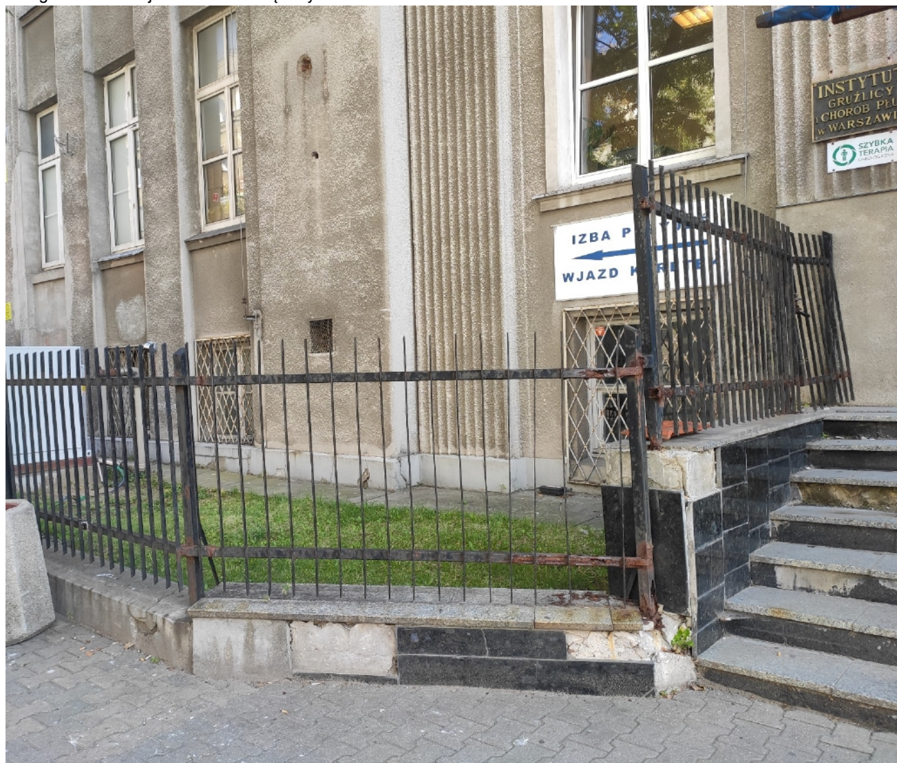
widok aktualny - elementy do rozbiórki
